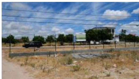
Figura 16: Terreno do futuro campus em Paulo Afonso, com cerca em gradil sendo construída.
